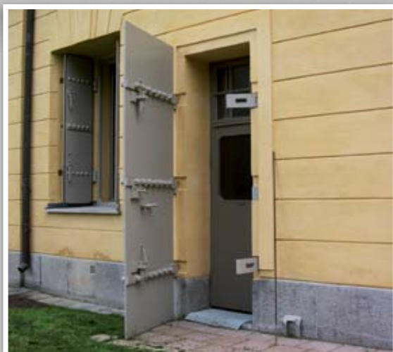
Bottenvåningen utformades som en bunker med väggar förstärkta av 1,2 meter tjock betong.
