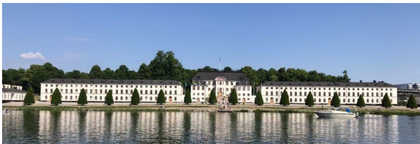
På Karlbergs slott i Stockholm har bland annat takrenovering pågått under 2021. Foto: Sara Krüger.
