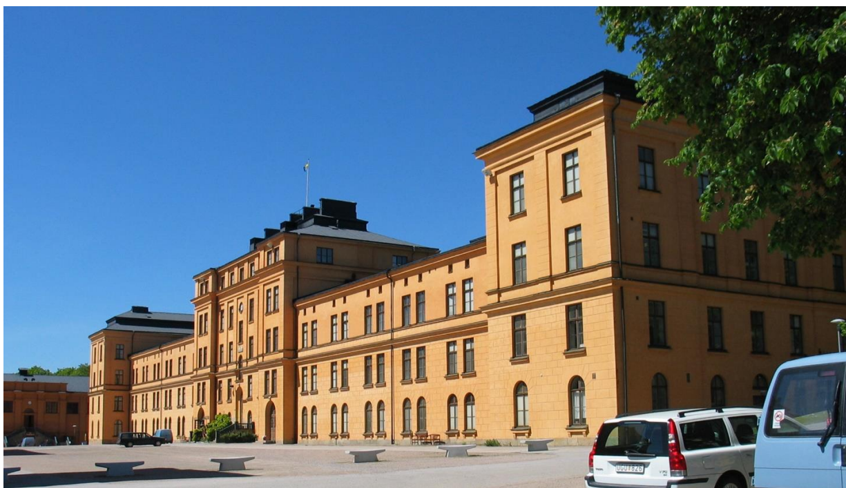
Kasernen Najaden i Karlskrona har under året renoverats. Foto: Ingela Andersson Lindberg, Fortifikationsverket.
