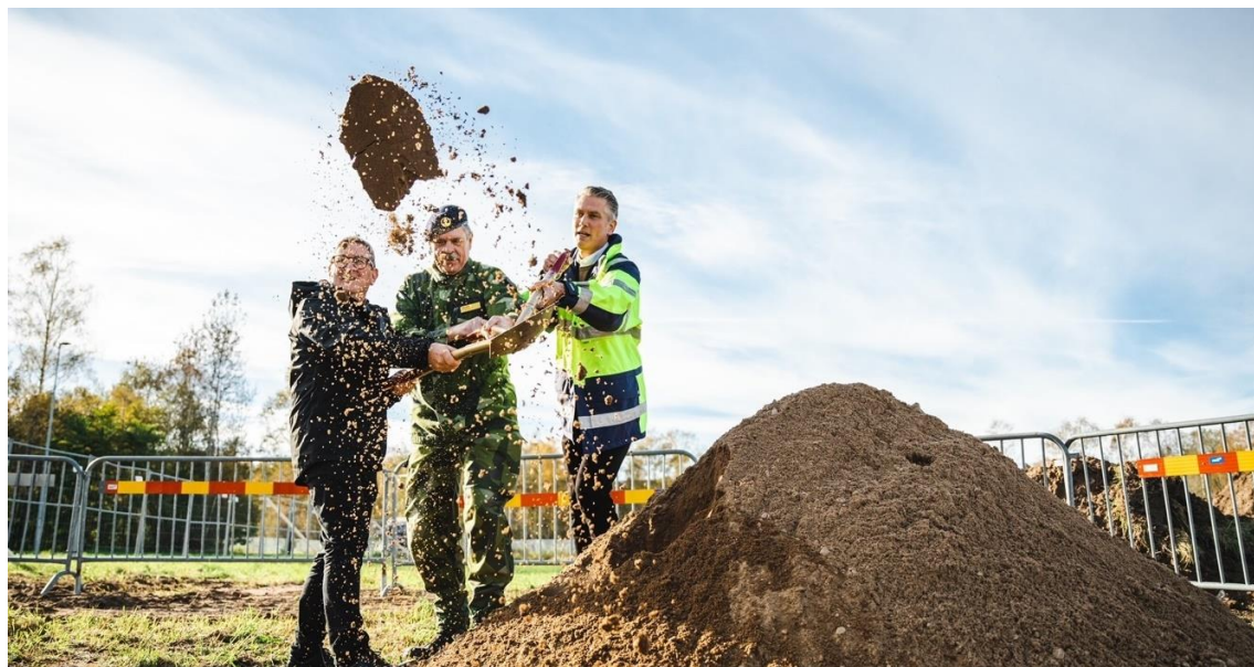
I oktober 2023 togs första spadtaget för en utbildningshall i Halmstad. Byggnaden blir en av Fortifikationsverkets största. Foto: Alexander Gustavsson, Försvarsmakten.
