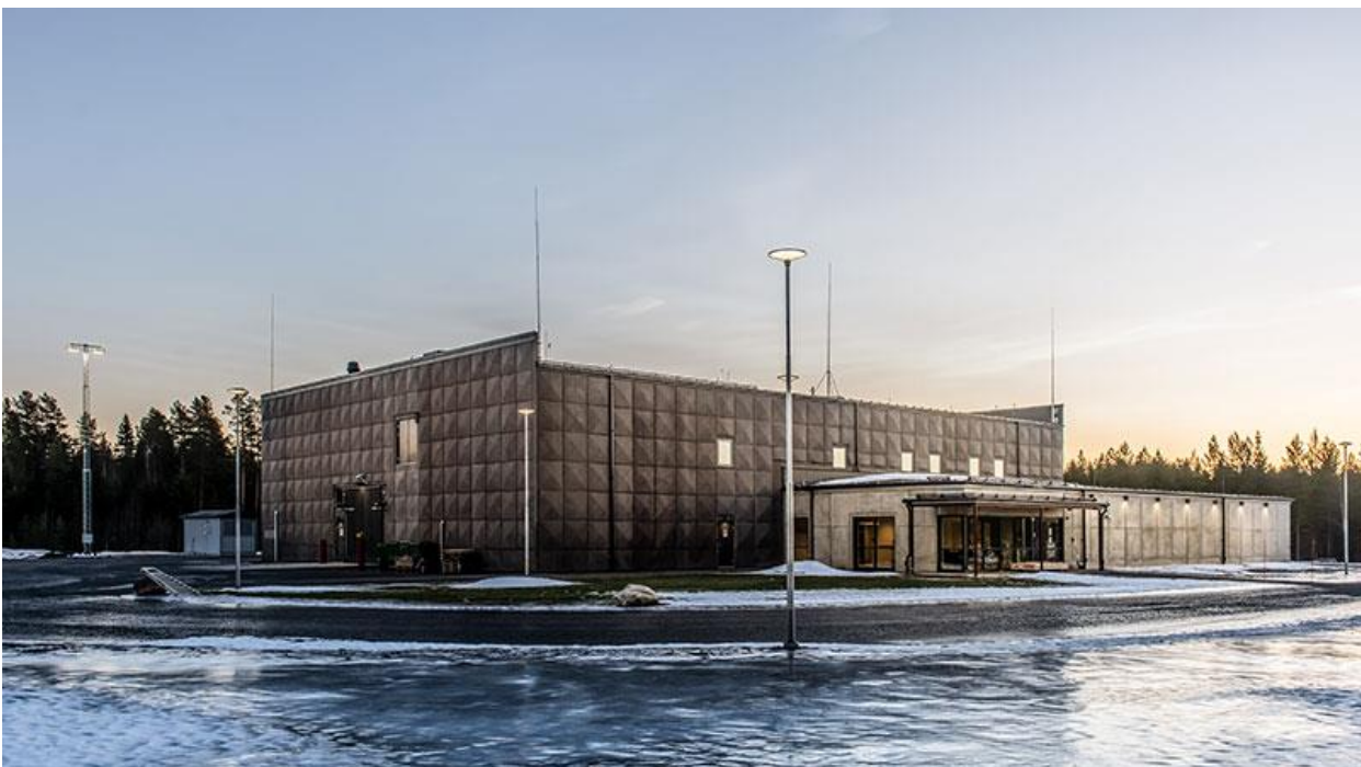
Den unika inomhusträningsanläggningen för CBRN i Umeå. Foto: Peter Malmrup
