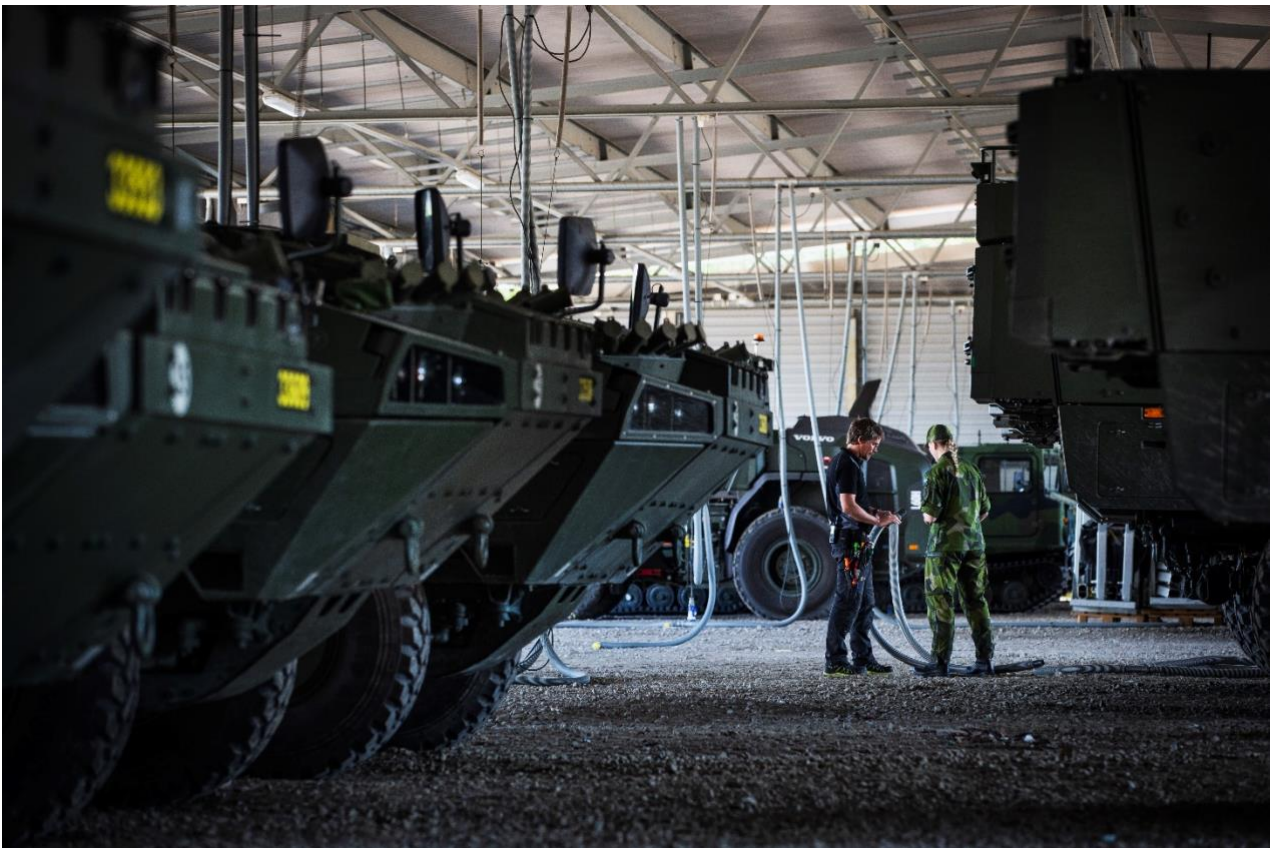
Fortifikationsverket förvaltar viktiga försvarsfastigheter som verkstäder och fordonshallar. Foto: Öyvind Lund.
