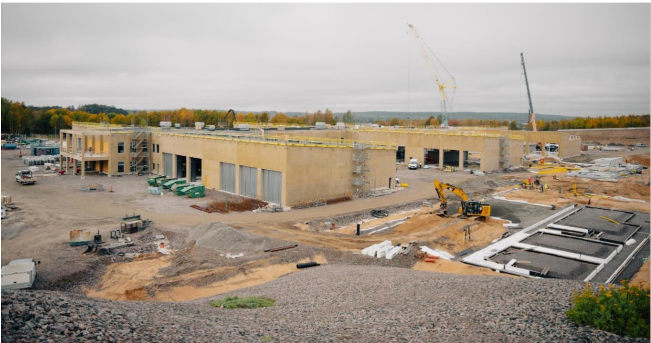
I Halmstad garnison pågår bygget av ny utbildningshall i luftvärn. Det första spadtaget togs i oktober 2023 och målsättningen är att hallen ska vara inflyttningsklar efter sommaren 2026. Foto: Alexander Gustavsson/Försvarsmakten
