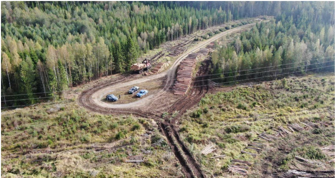
Trädfällning på Harberget i Kristinehamn. Här ska det nya regementet för Bergslagens artilleriregemente A 9 byggas. Foto: Fortifikationsverket.
